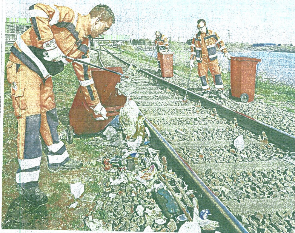
Prian Borth, Christian Heister und Simon Prante (v.l.) bei Aufräumarbeiten am Wendebecken, Heidbergsweg.
